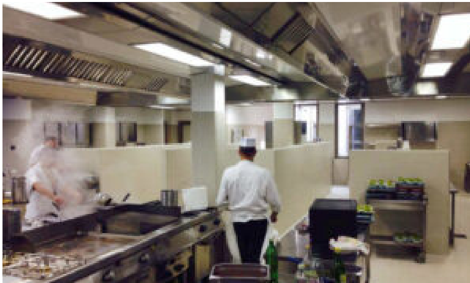
realizzazione soffitto aspirante presso la Esa Esrin
